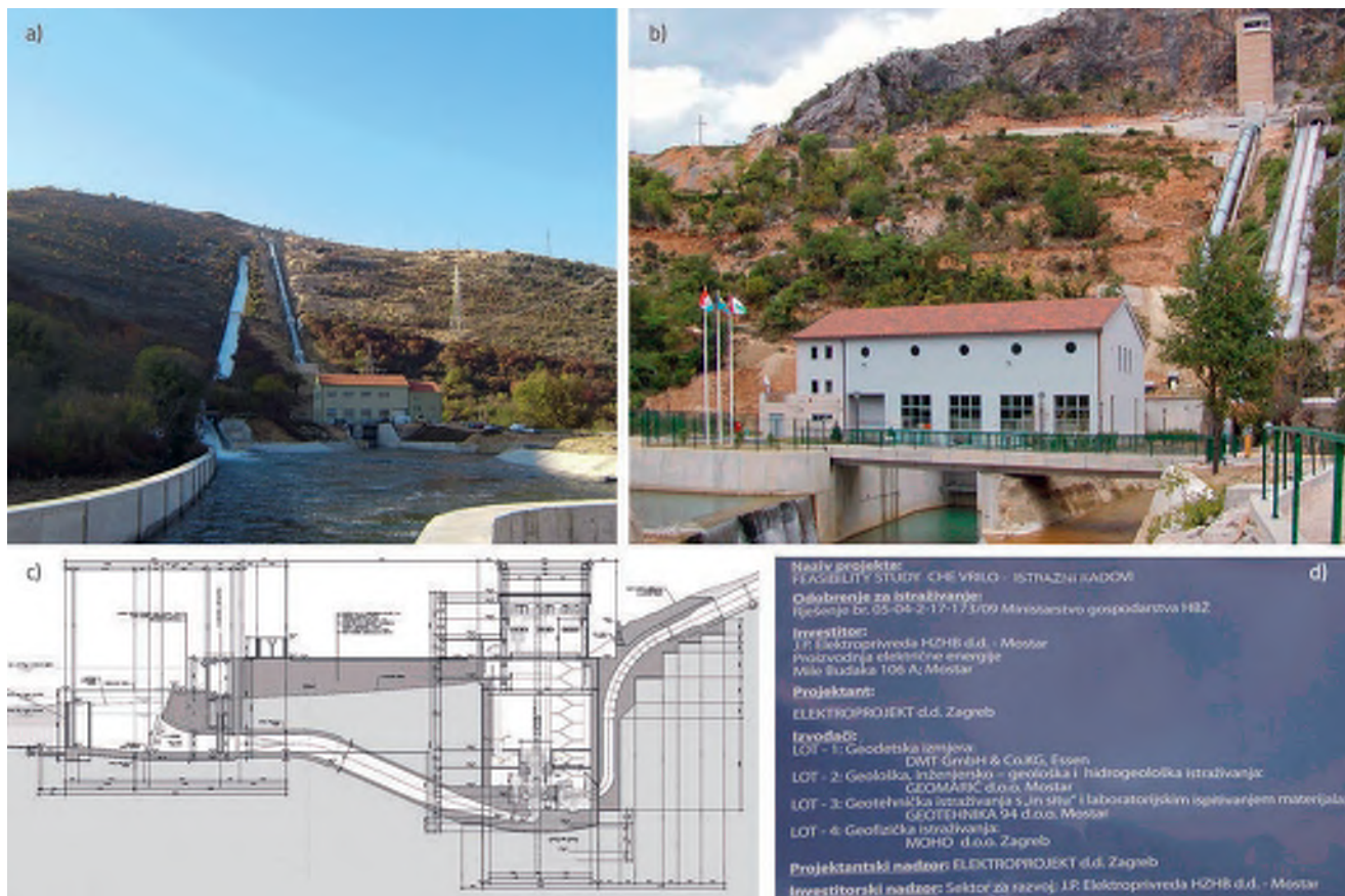
Hidroelektrane na području HZHB: a) HE Mostarsko blato; b) HE Peć Mlini; c) CHE Vrilo – presjek strojarнице; d) CHE Vrilo - Istražni radovi
