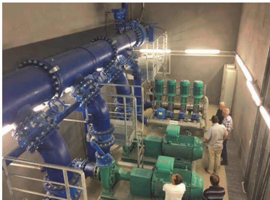
Crpna stanica Sustava navodnjavanja Kapinci – Vaška
