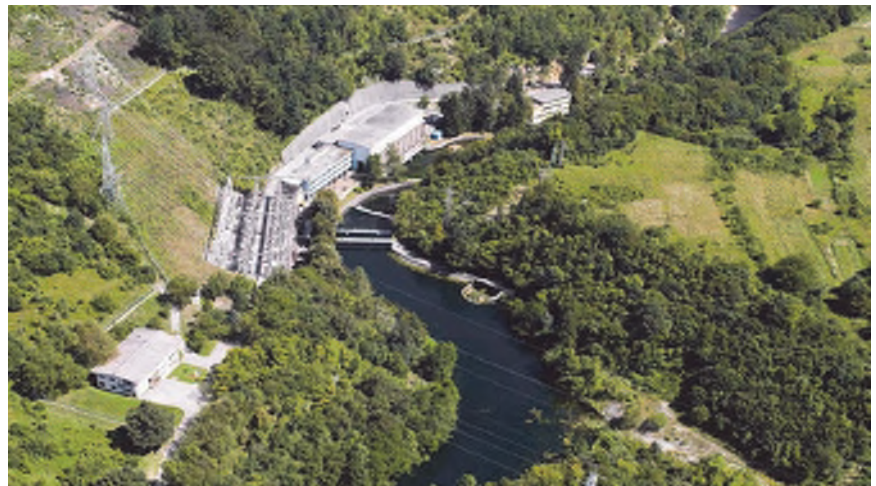
Prikaz HE Gojak u kojemu je izvedena rekonstrukcija strojarnice i izrađen elaborat zaštite okoliša
