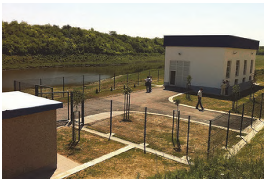
Crpna stanica Sustava navodnjavanja Opatovac
