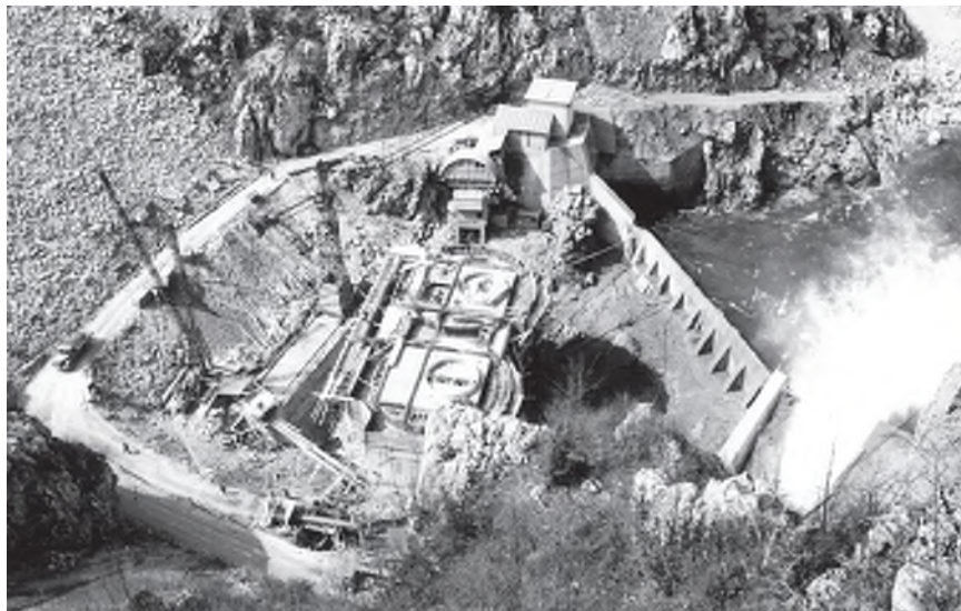
HE Sklope – izgradnja
