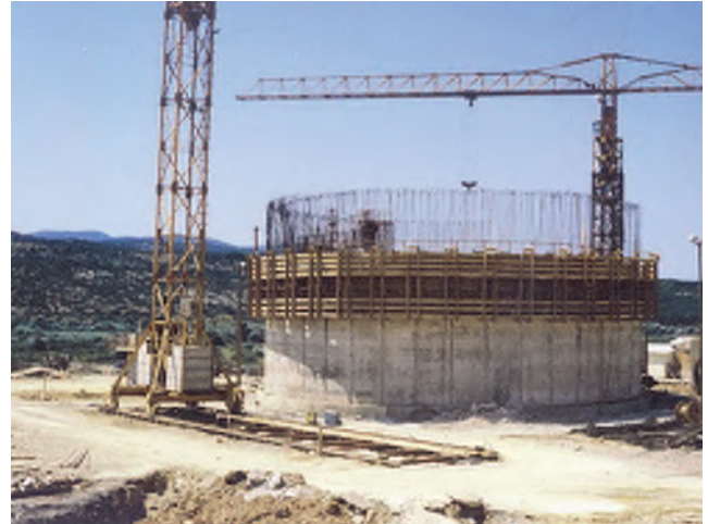
Spuštanje bunara strojarnice
