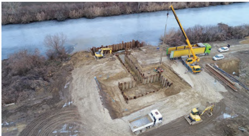
Izgradnja crpne stanice Sopot
