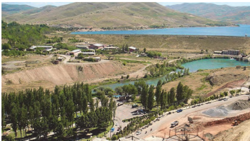
Višenamjenski projekt Mahabad u Iranu, akumulacija Mahabad
