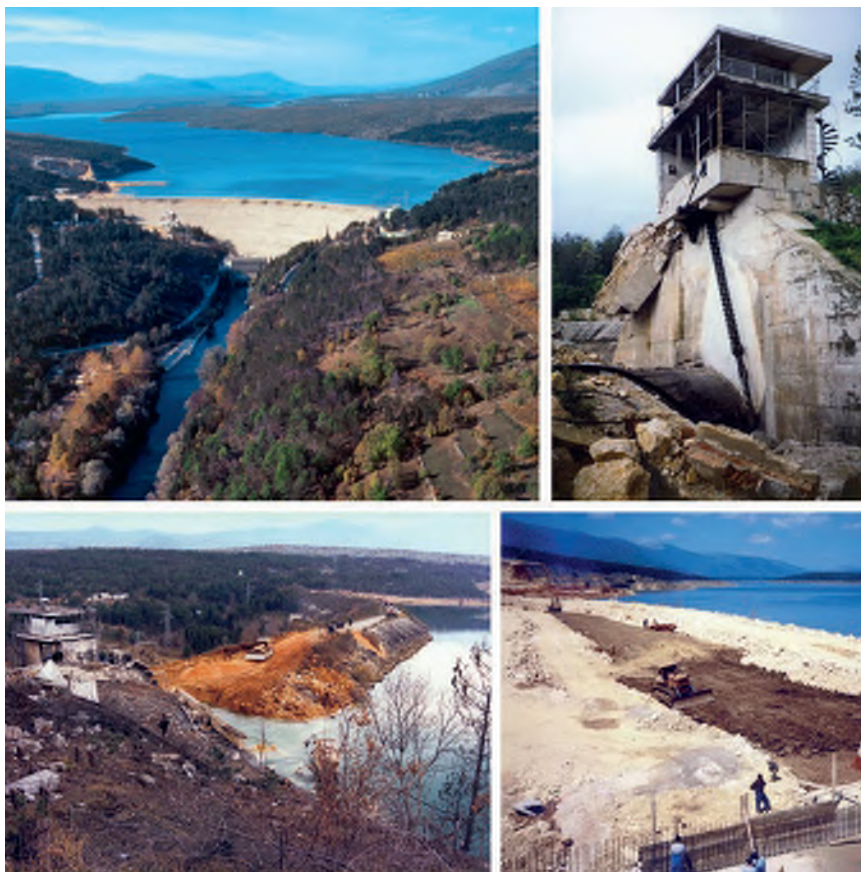
HE Peruča - brana, akumulacija i strojarica – sanacija nakon miniranja 1993. godine
