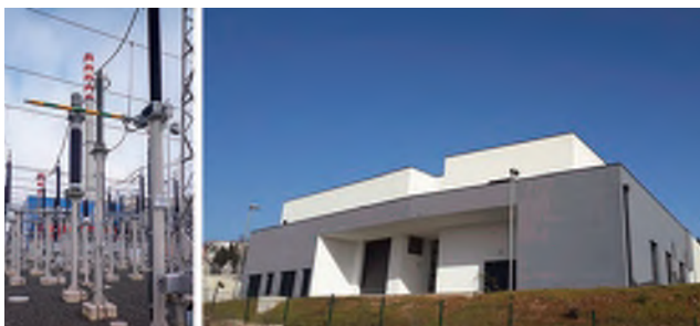
KKE Sisak – rasklopište; TS Zamet
