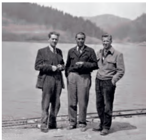
Izgradnja HE Vinodol
